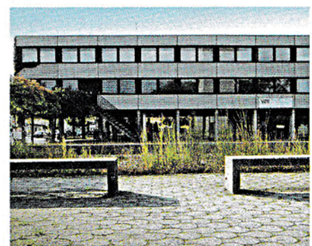
Der Bestand: Energetisch problematisch und mit vielen konstruktiven und strukturellen Schwächen.
