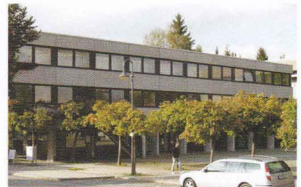
Zustand vor der Sanierung
